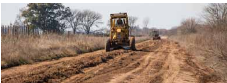
Máquinas trabajando en un camino rural
